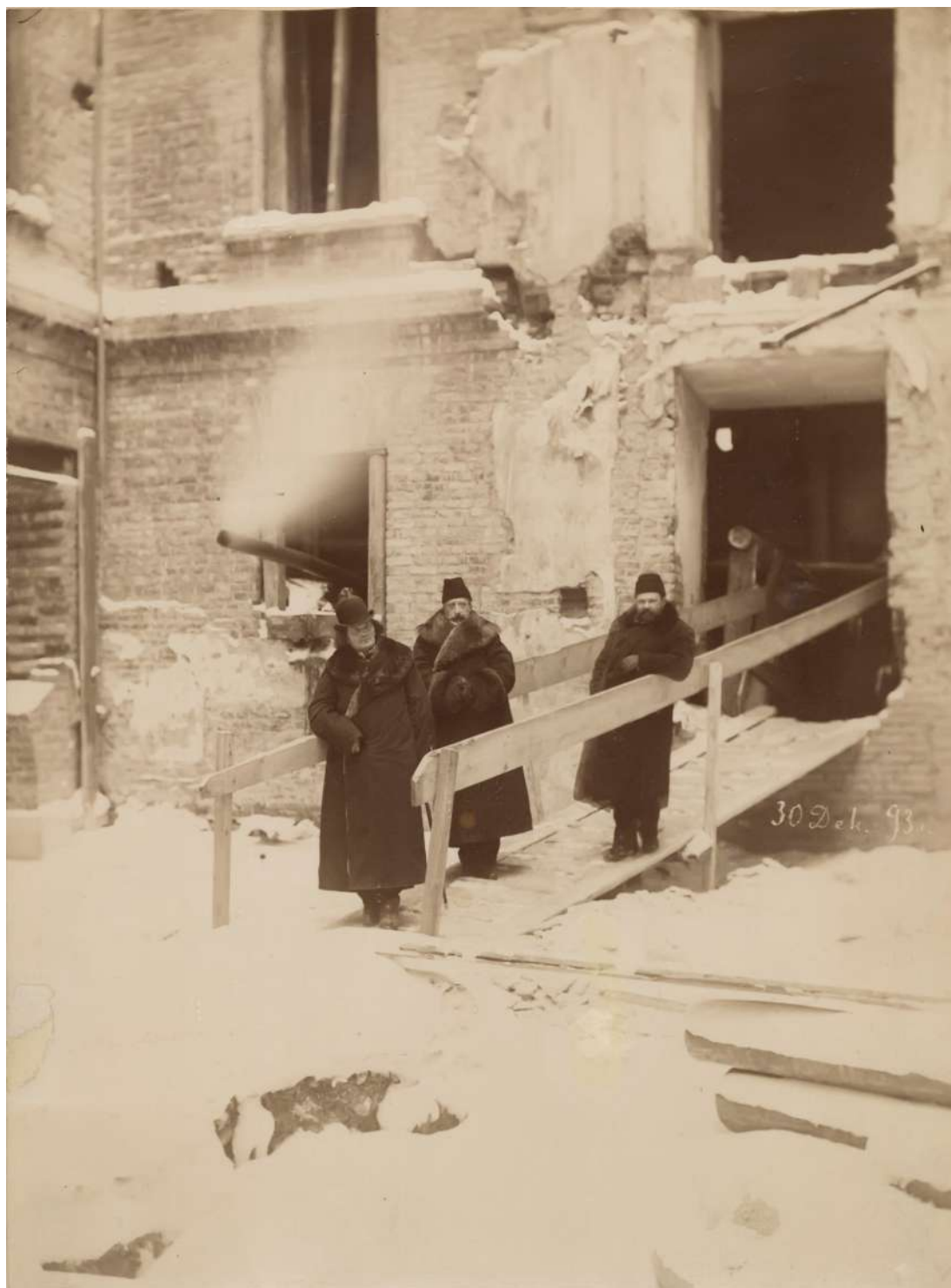
44. А. Г. Рубинштейн, В. А. Тур и В. В. Никола на строительной площадке Консерватории. Фото. 1893
